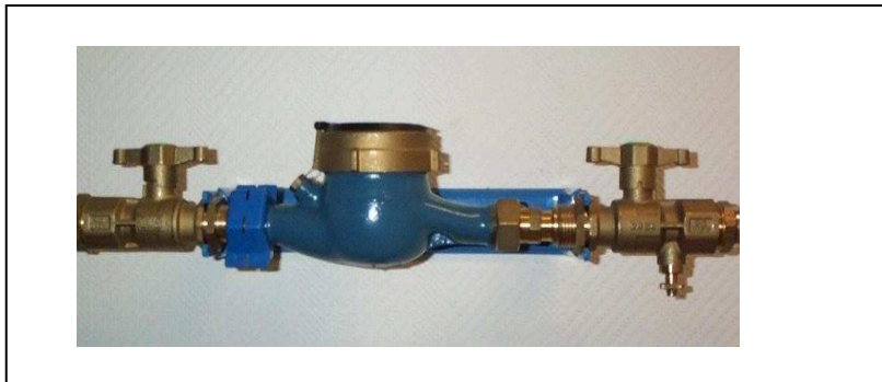
Einbauvorgabe nach DIN 1988 / EN 806-2
