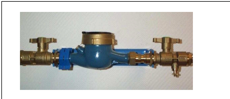
Einbauvorgabe nach DIN 1988 / EN 806-2
